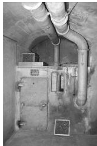
Feinpartikel-Atomschutzfilter Filtro fine di protezione da pulviscolo atomico
