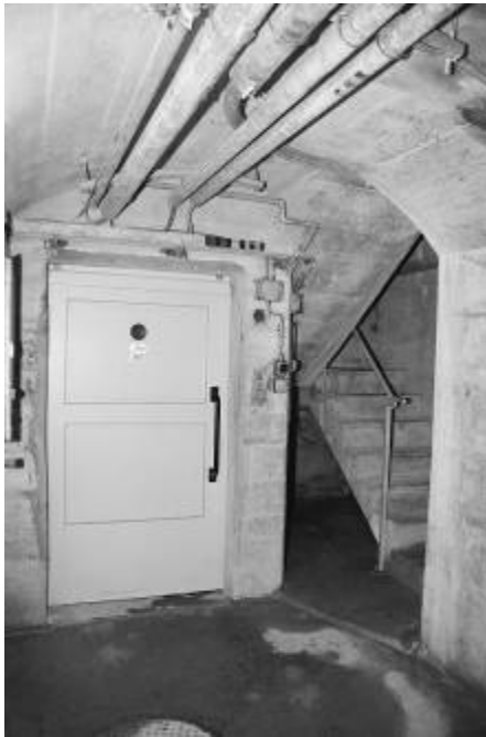
Lift Nr. 1 und Treppe im Untergeschoss Piano inferiore: ascensore n. 1 e scala
