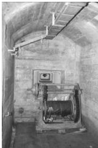
Eingangverteidigungs-Bunker Rohrwechselwinde zum 10,5 cm PzT Fortino della difesa d'ingresso Argano per il cambio della canna del cannone 10,5 cm
