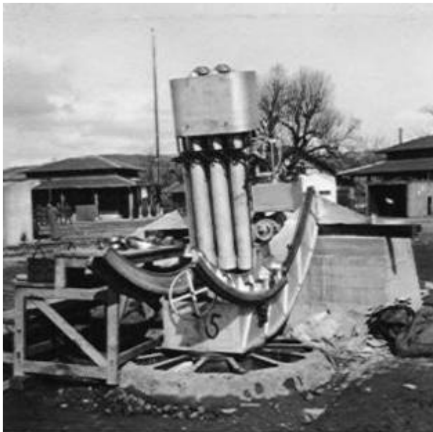
Montage für Schiessversuche des für Foppa Grande vorgesehenen 12 cm Mehrfachminenwerfers in Thun; noch fehlt die Ladebühne aus Holz
