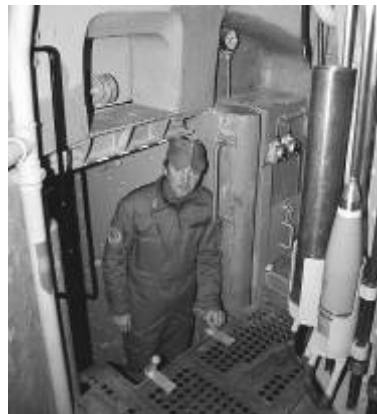
Einstieg mit Munitionsdurchreiche in den Turm der 10,5 cm Turmkanone Entrata e approvvigionatore di muni- zioni nella torretta del cannone da 10,5 cm
