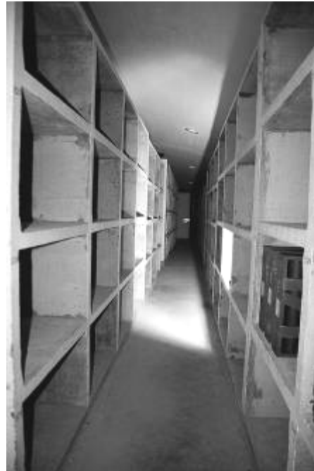
Munitionsmagazin mit Betonkasten Magazzino delle munizioni con compartimenti di calcestruzzo
