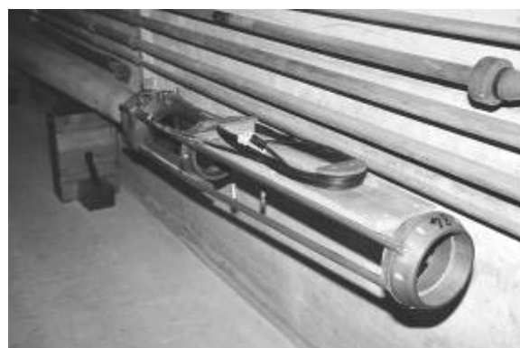
Vo-Messeinrichtung auf 10,5 cm Ersatzrohr Dispositivo di misurazione V o sulla canna di ricambio del cannone
