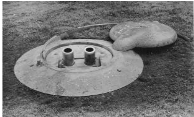
Lm fort 12 cm 59 Foppa Grande senza mascheramento Geöffnet mit ausgefahrenem Zwillingswerfer Coperchio corazzato aperto e canne del lm sporgenti
