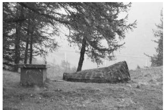
Tarnung 12 cm Fest Mw 59 Foppa Grande und Abluft UG Mascheramento del Im fort 12 cm 59 Foppa Grande con uscita dell'aria viziata proveniente dal piano inferiore
