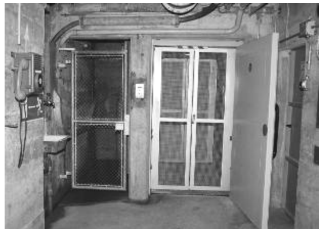
Lift- und Notleiterschacht Nr. 2 zum 12 cm Fest Mw 59 Pozzo n. 2 dell'ascensore e della scala d'emergenza verso il Im fort 12 cm 59
