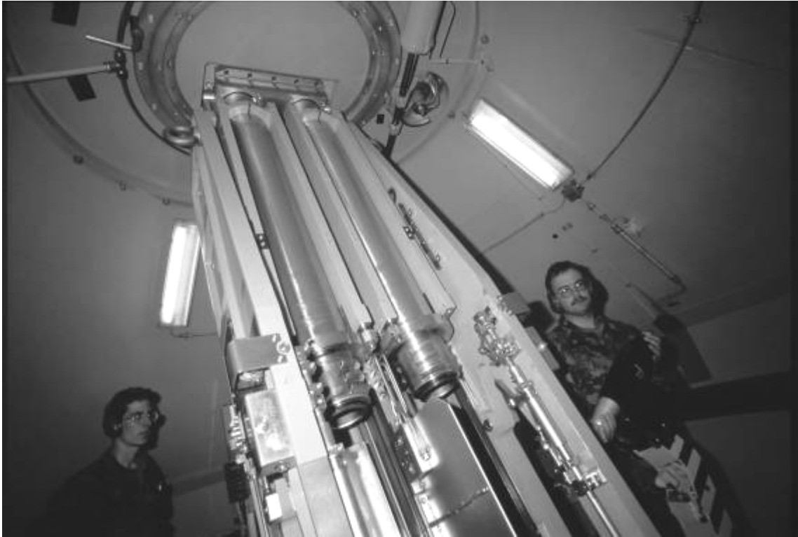
12 cm Fest Mw 86: Lader im Geschützraum Lm fort 12 cm 86: caricatori nel vano del pezzo
